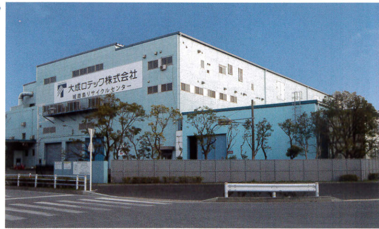
大成ロテック株式会社 城南島リサイクルセンター全景
